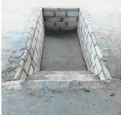
Foto 3: Fosa terminada para uso de taller
