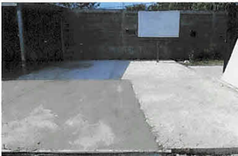
Foto 5: Torta de concreto de 8cms de espesor, 75 m2, terminada
