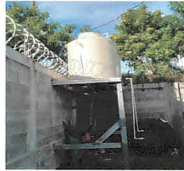
Foto 2: instalación del tinaco
