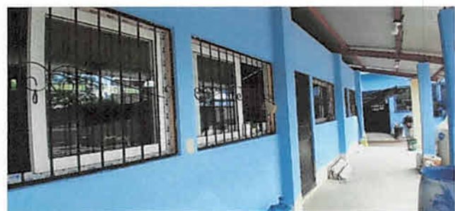
Foto 6: Instalación de ventanas de pvc
