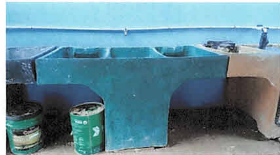
Foto 4: Instalación de pila de dos lavaderos
