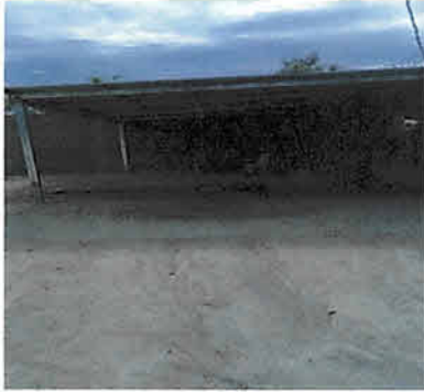
Foto1: Terminación de la nueva galera para area de taller y su instalación electrica
